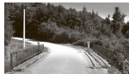
Popravljeni most vodi u Mlakovac
