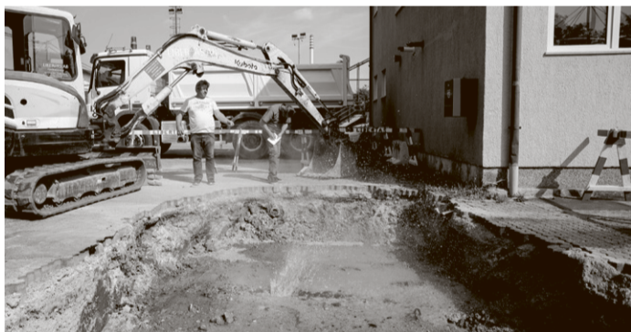
Sanacija puknuća vrelova u Zagrebu (Foto: Davor Puklavec/PIXSELL)
