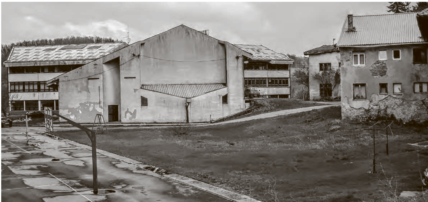
Kompleks u kojem je smještena Područna škola Drežnica
