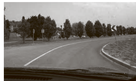
Nova cesta od kružnog toka do Suljoških bazena
